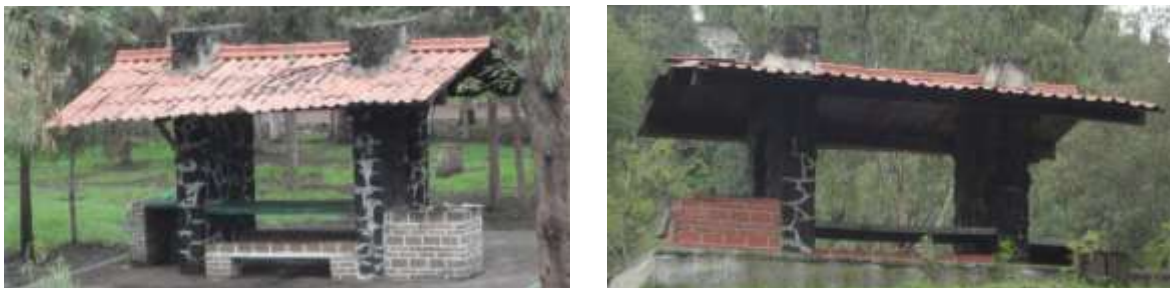
Figura 17. Estado actual de las cabañas.
