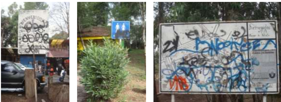
Figura 24. Fotografías del estado actual de los señalamientos del AVABN.
