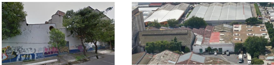
Ilustración 69 Pino No. 328: Instalaciones fabriles
