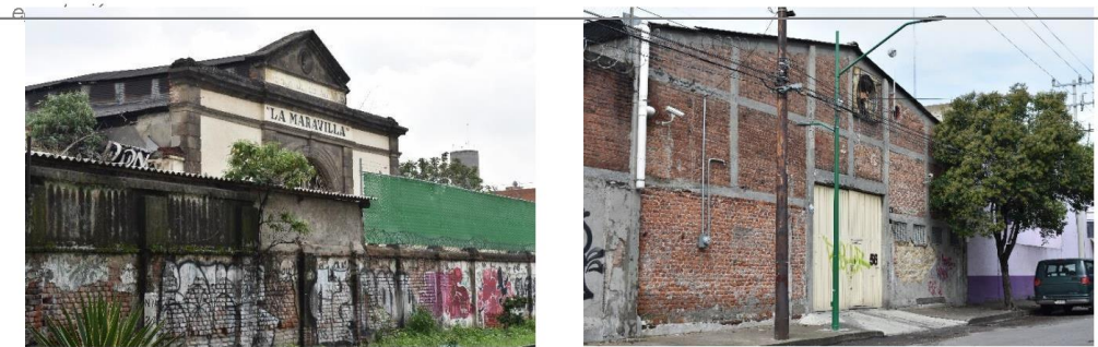
Ilustración 92 Antigua Fábrica "La Maravilla" y Edificio industrial en condiciones de d
