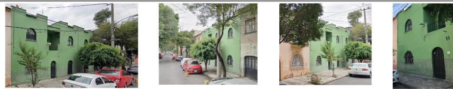
Ilustración 80 Lirio No. 11: Inmueble habitacional.
